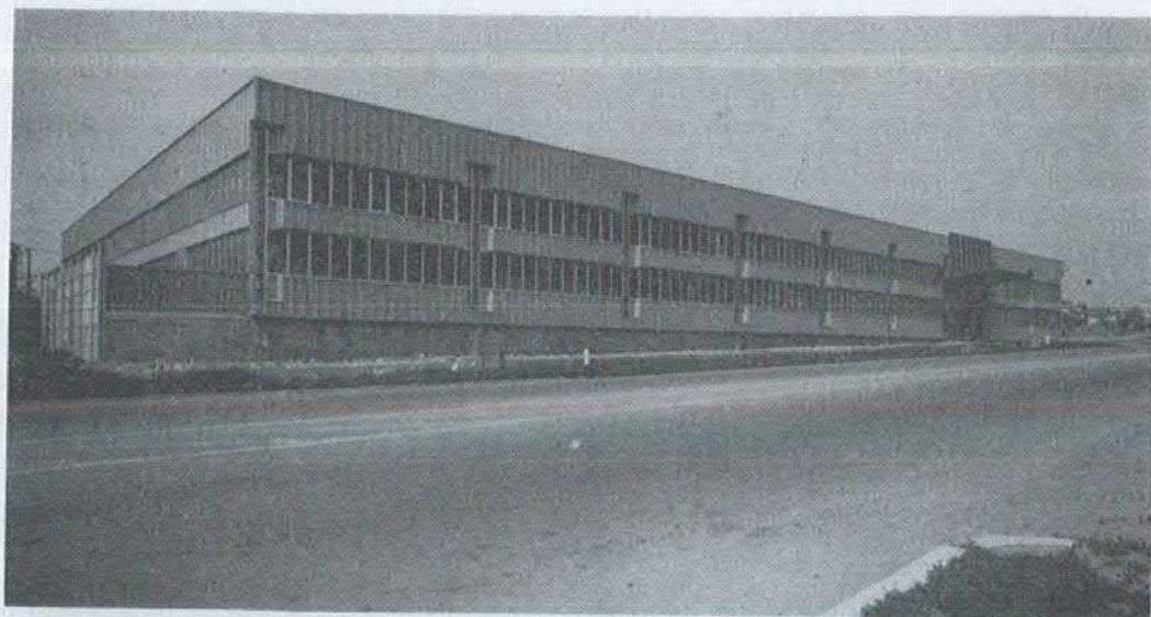
Veduta generale dell'edificio industriale realizzato in Piemonte, dalla Ditta Volani, con il sistema dell'edilizia industrializzata.
